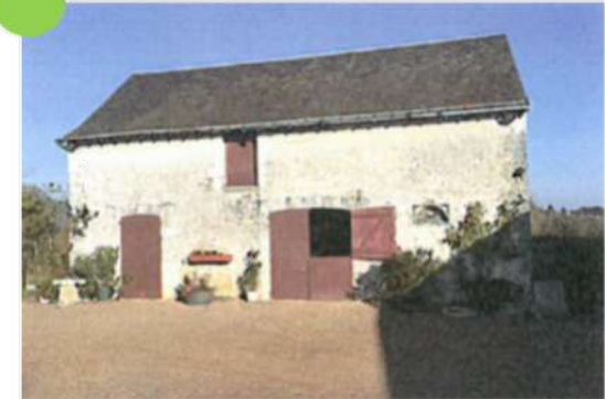
Bâtiment conforme aux critères de repérage
