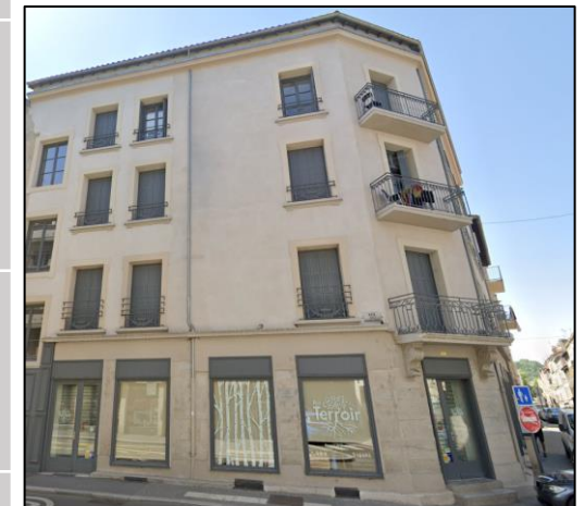
Après travaux Source : Google maps
