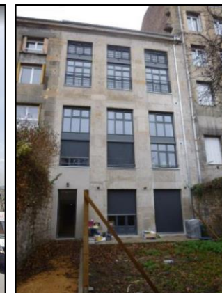
Après travaux Source : ANAH / Google maps
